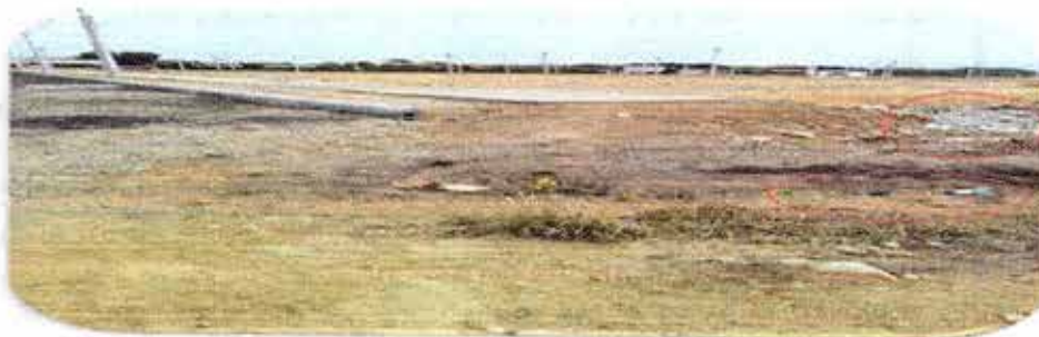
FIGURA 10 SARDINEL Y CALLE PAVIMENTADA
