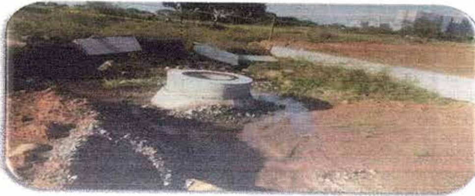
FIGURA 6 ADECUACIÓN DEL TERRENO PARA CONSTRUCCIÓN.
