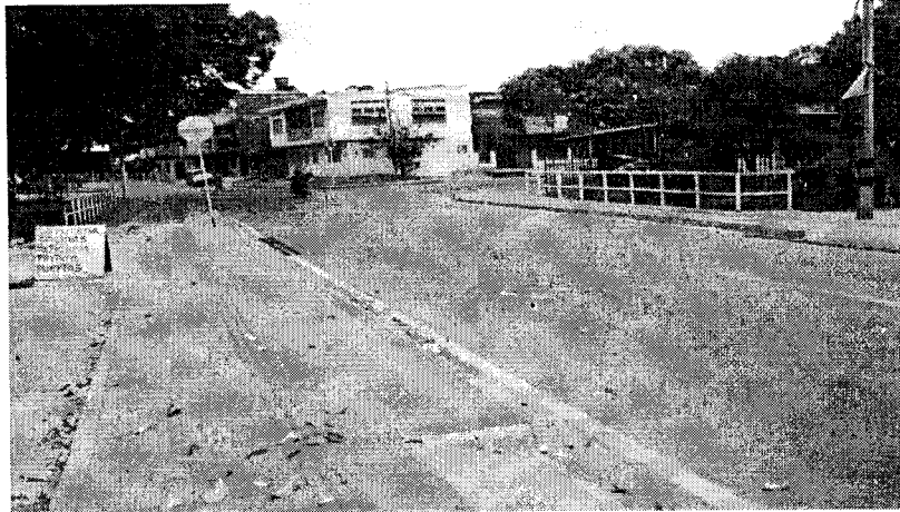
Via intervenida – Calle 2 Sur entre Carrera 15 y Carrera 21 – FASE II
