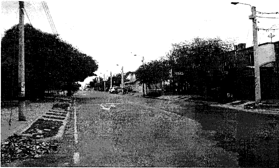
Vía intervenida – Calle 24 Sur entre Carrera 40 y Carrera 34 – FASE I
