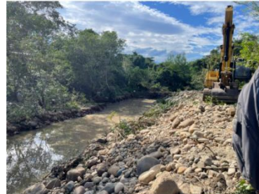
Imagen 2. Intervención cauce Rio del Oro Margen Izquierda
