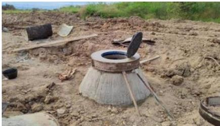
Imagen 4. Construcción de pozos y colocación de la respectiva tapa metálica
