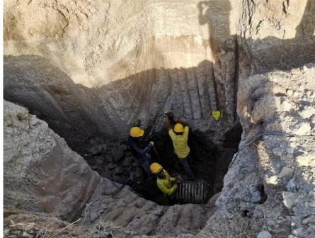
*Imagen 2. Estrato rocoso en sitio de construcción de pozo de inspección*
