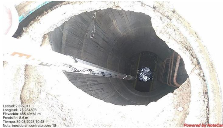
Imagen 2. Anillo de concreto pozo No. 5
