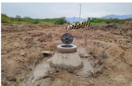
Imagen 5. Tapa metálica y corona en concreto
