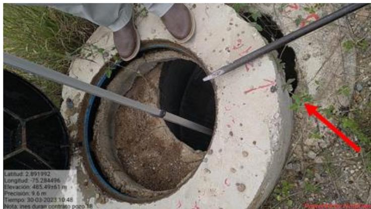
Imagen 1. Anillo de concreto desalineado al eje vertical del pozo de Inspección
