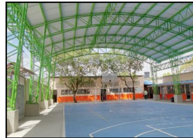
Imagen 42 espacios más urgentes de mantenimiento
