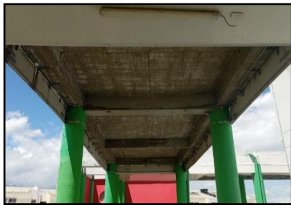
Imagen 55 espacios más urgentes de mantenimiento
