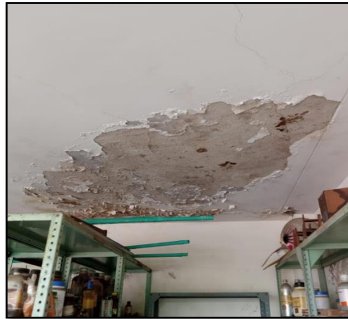
Imagen 26 espacios más urgentes de mantenimiento
