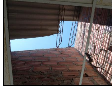
Imagen 34 espacios más urgentes de mantenimiento
