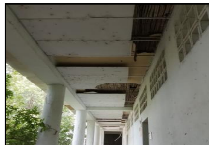
Imagen 44 espacios más urgentes de mantenimiento
