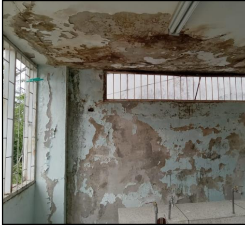
Imagen 25 espacios más urgentes de mantenimiento
