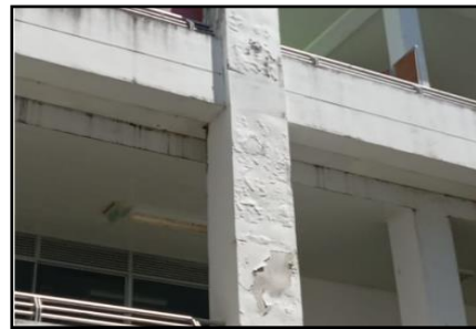
Imagen 56 espacios más urgentes de mantenimiento
