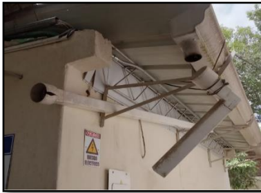
Imagen 41 espacios más urgentes de mantenimiento
