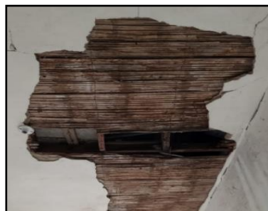
Imagen 43 espacios más urgentes de mantenimiento
