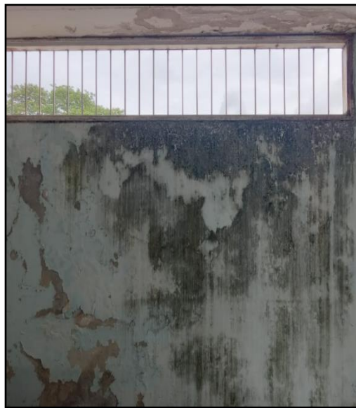
Imagen 27 espacios más urgentes de mantenimiento
