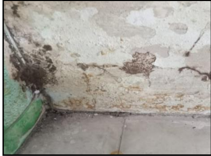
Imagen 33 espacios más urgentes de mantenimiento
