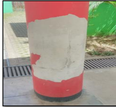
Imagen 54 espacios más urgentes de mantenimiento
