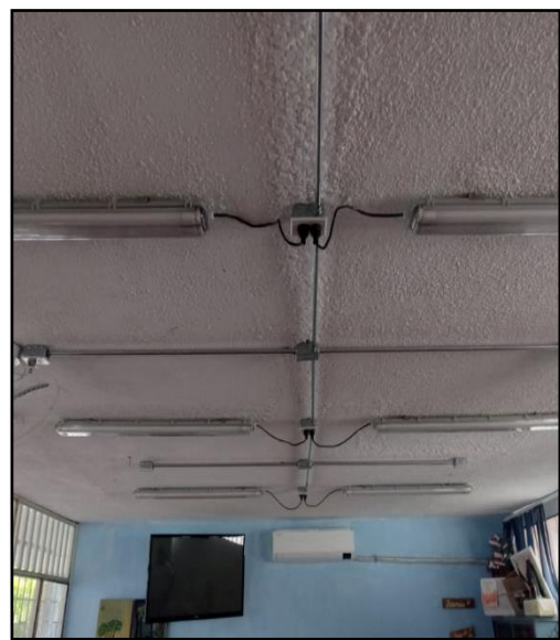
Imagen 28 espacios más urgentes de mantenimiento
