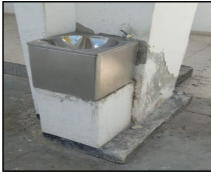
Imagen 53 espacios más urgentes de mantenimiento
