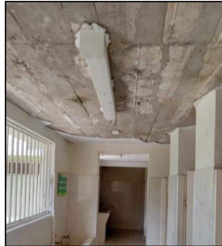
Imagen 36 espacios más urgentes de mantenimiento
