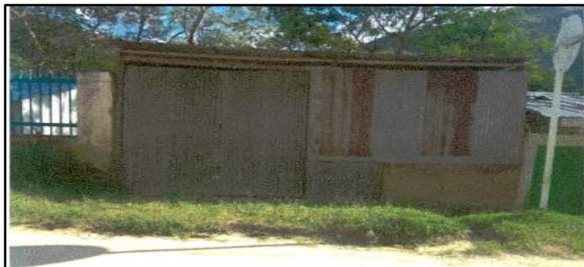
Imagen N° 26 Construcción existente en El predio Pueblo Nuevo
